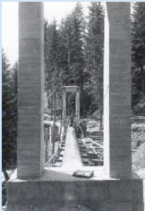
Oben links: Bau der Hängebrücke für die Druckrohrleitung. Oben rechts: Das ehemalige „Spatzenhäusl“ musste nach einem Hangrutsch entfernt werden.
