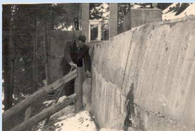
Unten: Begutachtung der Betonrohrleitung im Jänner 1958. Fotos: EWG
